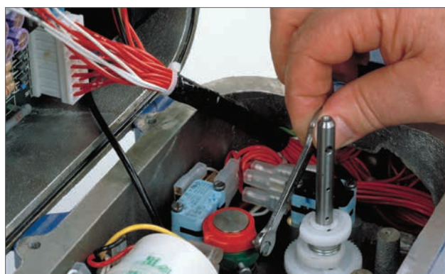
Einstellung Drehmomentschalter
